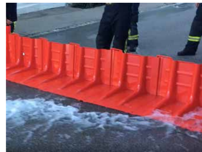
Im Rahmen einer Übung wurde bereits das Hochwasserschutzsystem aufgebaut und hielt selbst direkt anströmendem Wasser stand. Damit sind Stauhöhen von 50 cm möglich.
